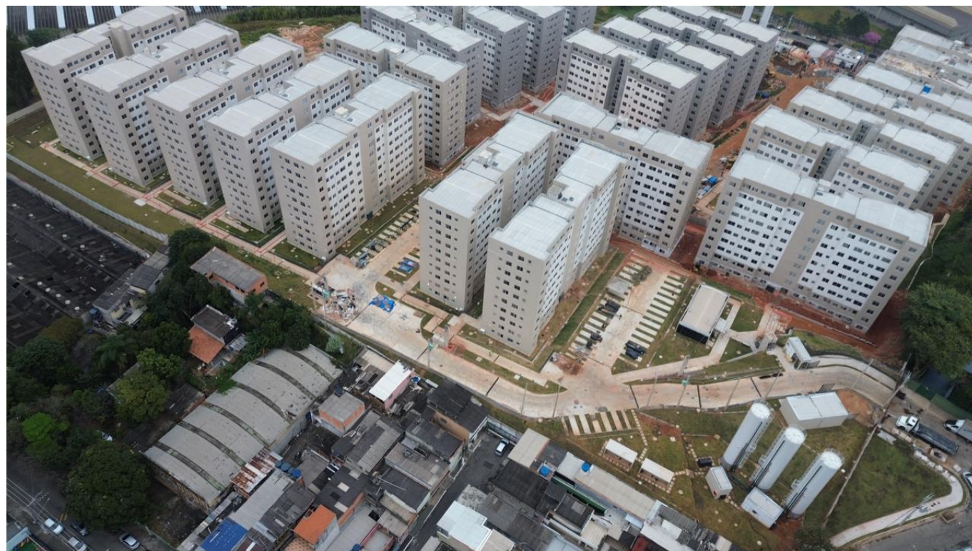
CITTÁ 01 – CONCLUSÃO FÍSICA SETEMBRO 26 (+22M)
