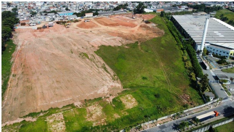
INICIO DE OBRA – DEZEMBRO 24
