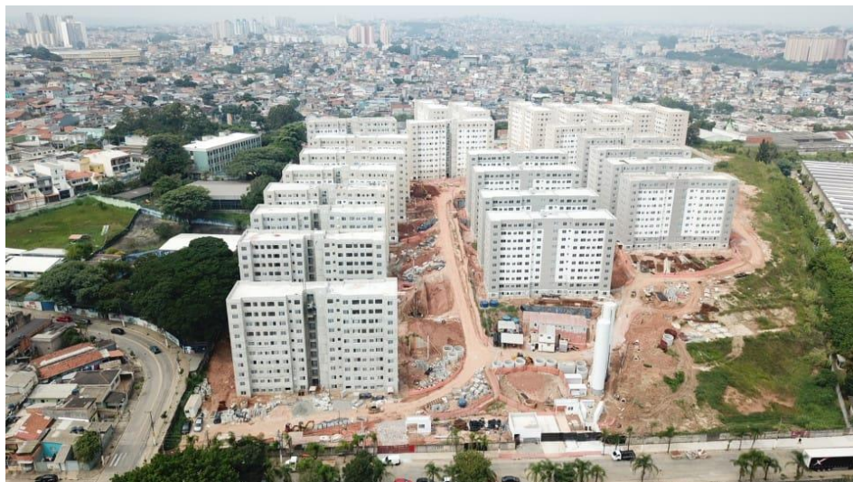
TÉRMINO DE ESTRUTURA – JANEIRO 26 (+12M) 25 TORRES – 2.000 UNIDADES
